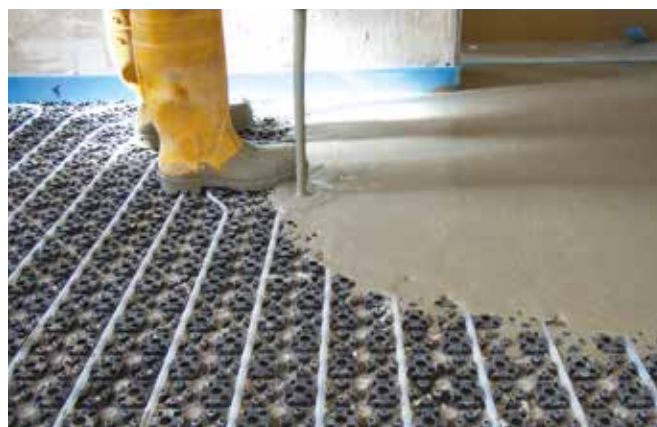
Dressage de surface et mise à niveau de planchers et chapes
