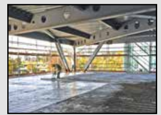
1 Béton structurel léger en argile expansée Laterlite. 2 Armature.
