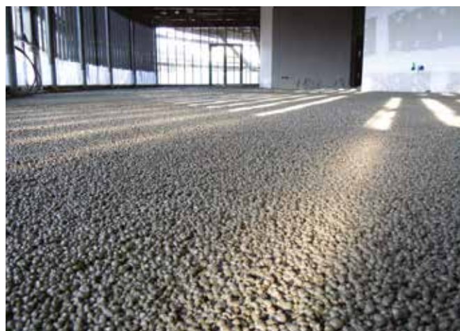
Remplissages légers et isolants (voûtes, etc.)
