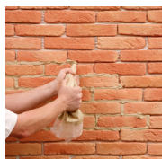
2 - Je réalise les joints
