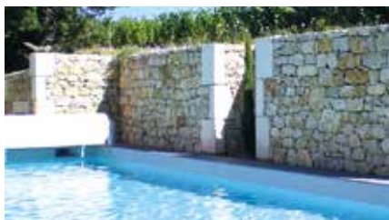
Murs de soutènement
